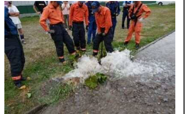
漏水現場の様子
