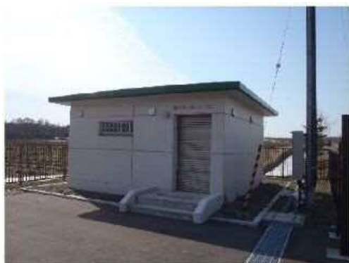
写真 2-3 西島松増圧ポンプ場
