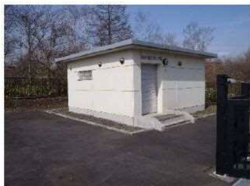
写真 2-4 柏木増圧ポンプ場
