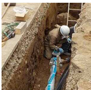
管路工事の様子
