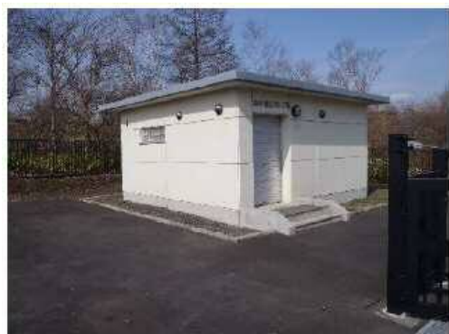
写真 2-4 柏木増圧ポンプ場
