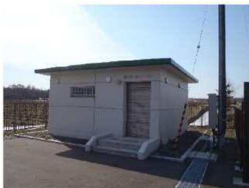
写真 2-3 西島松増圧ポンプ場
