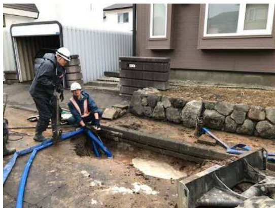
漏水現場と復旧工事
