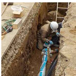
管路工事の様子
