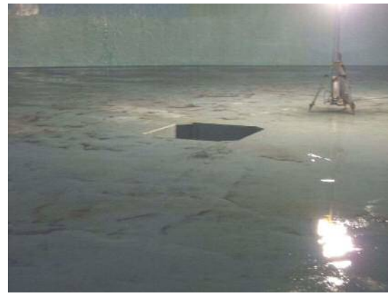
図-3.1.4 柏木配水池（内部）
