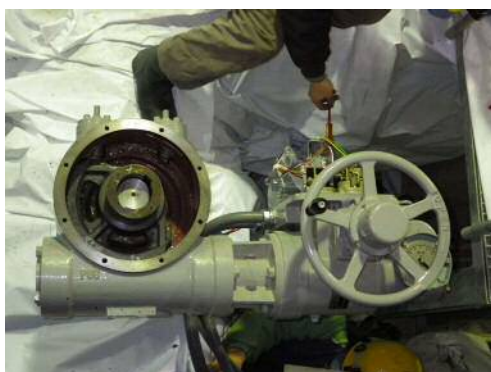
図-3.5.1 電動バルブ（点検時）
