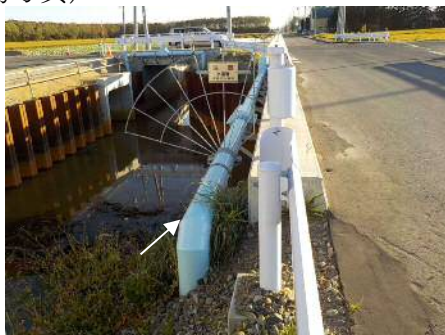
図-3.3.1 橋梁添架管（排水橋）
