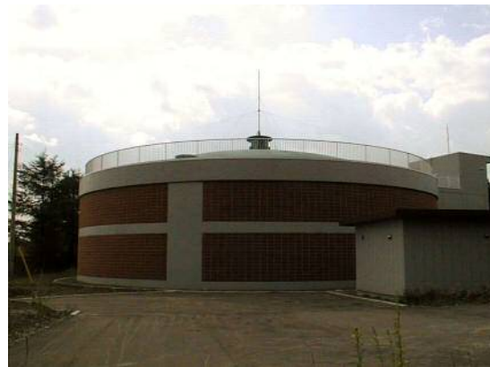
図-3.1.2 柏木配水池（外部）
