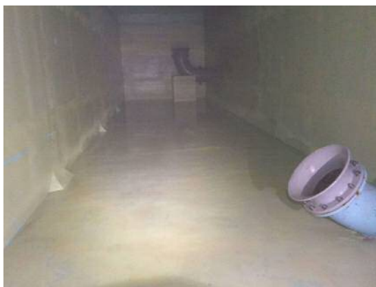
図-3.1.3 牧場配水池（内部）
