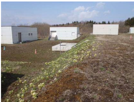
図-3.1.1 牧場配水池（外部）
